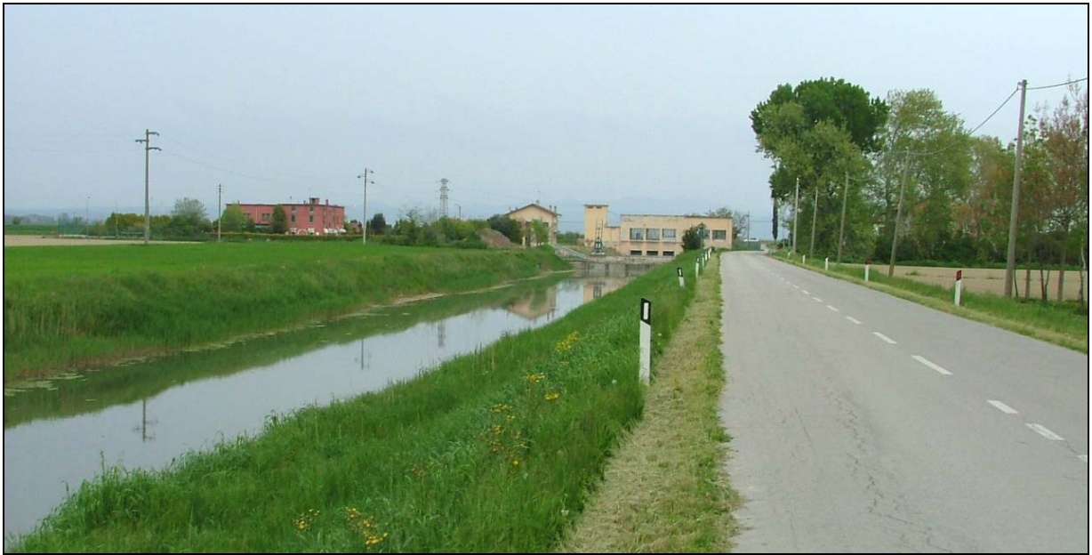
Canale collettore e viabilità principale nei pressi dell'idrovora
